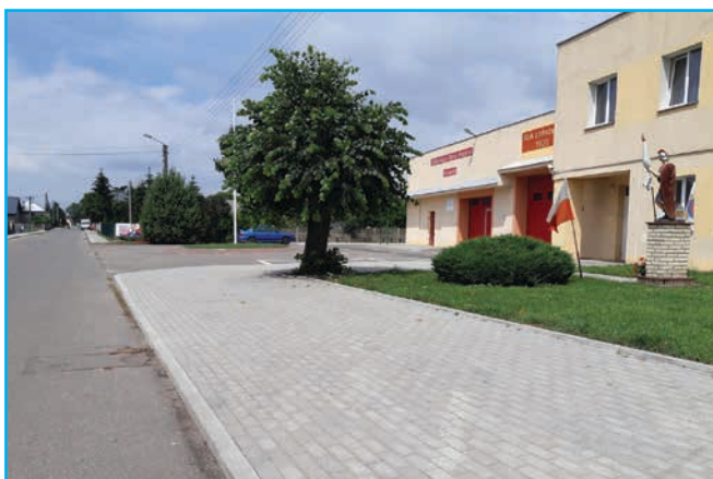
Nowe nawierzchnie na deptakach przy strażnicy OSP
