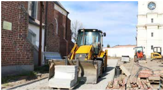
Prace wokół uniejowskiej Kolegiaty trwają
